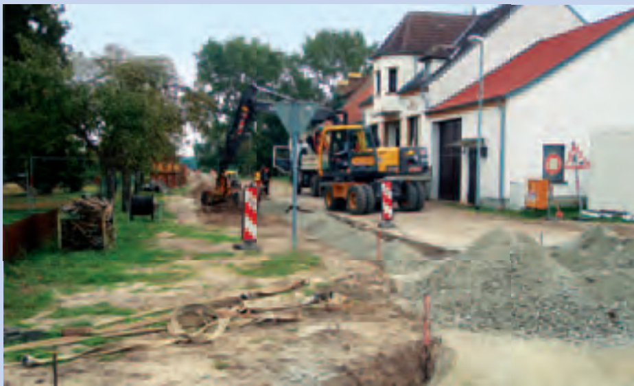
Die abwasserseitige Erschließung in Zülichendorf läuft planmäßig.
