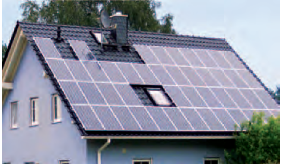
Photovoltaik-Dachanlagen sind keine Seltenheit mehr. Die SBL schätzen für das kommende Jahr einen weiteren Zuwachs von neuen Anlagen mit 1.000 bis 1.200 kW Leistung.
