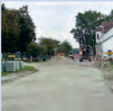
Im September und Oktober 2010 erfolgte der Straßenbau im Bereich der Schule.
